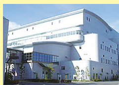
現在稼働中の 明石市クリーンセンター
